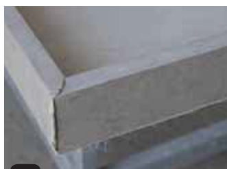
6 Durch den Druck quillt der Kleber aus der Fuge – kein Nachspachteln erforderlich
